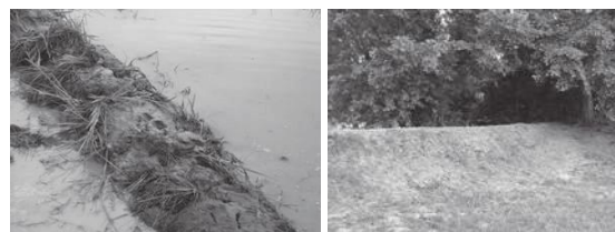
Figure 1 – Diguettes en terres et digue couverte de vétivers à Malanville
