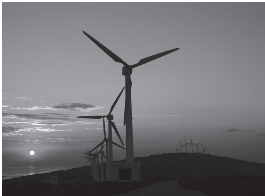
Vue de la centrale éolienne de Haouaria (54 MW)
