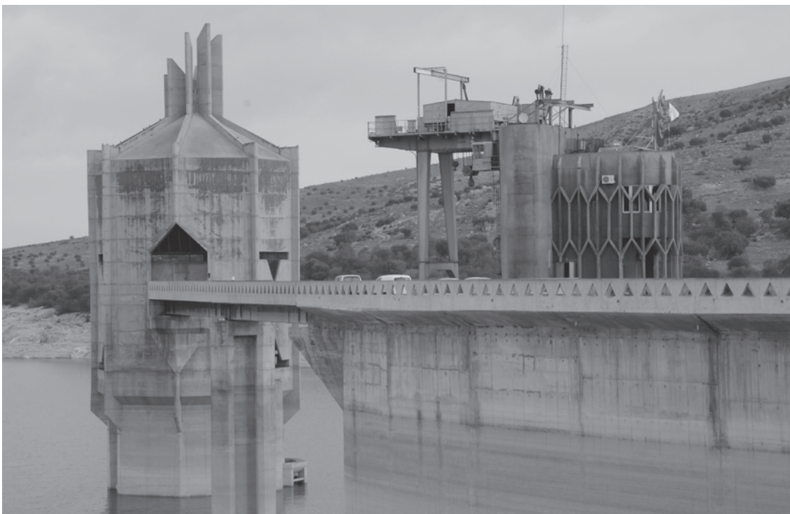
Vue de la centrale hydraulique de Sidi Salem (36 MW)
